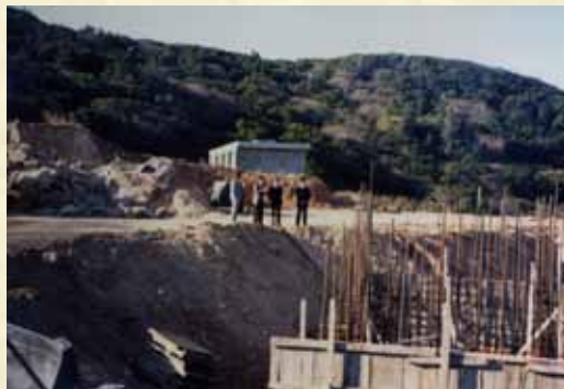
77.12.18 曾首席蒞臨馬祖勘察連江司法大樓工程
